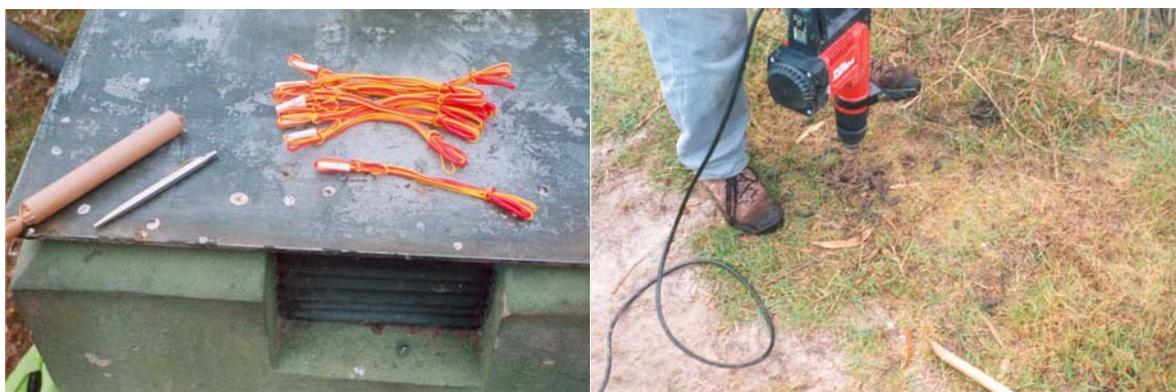
**Fig. 245. Cartuchos y detonadores utilizados (izquierda). Perforadora para hacer el taladro donde introducir los cartuchos (derecha)**
